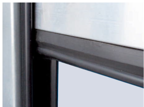
Coulisse en acier galvanisé avec patin de glissement, lame finale et joint
