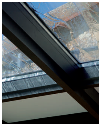
Test de performance d'étanchéité à l'eau (Test in Situ)
